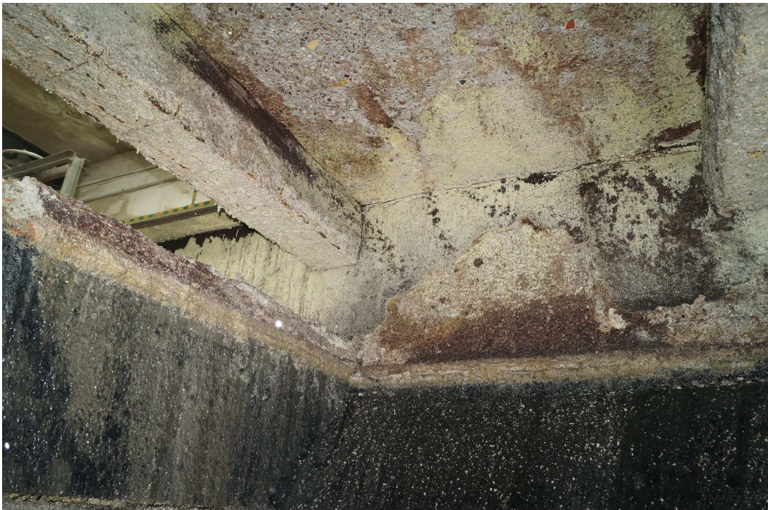
Zdj. 4) Płyta stropowa łapacza piasku – widok od spodu
